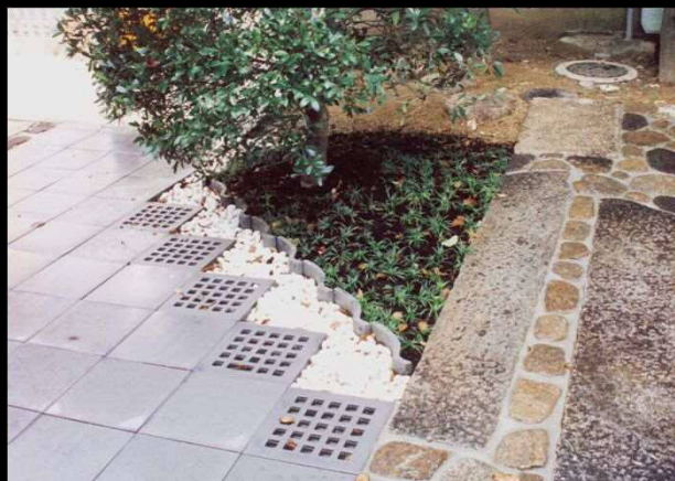
白玉石と平瓦積、延段の再現
