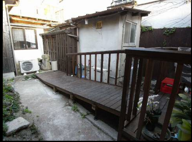
木製デッキスロープ
